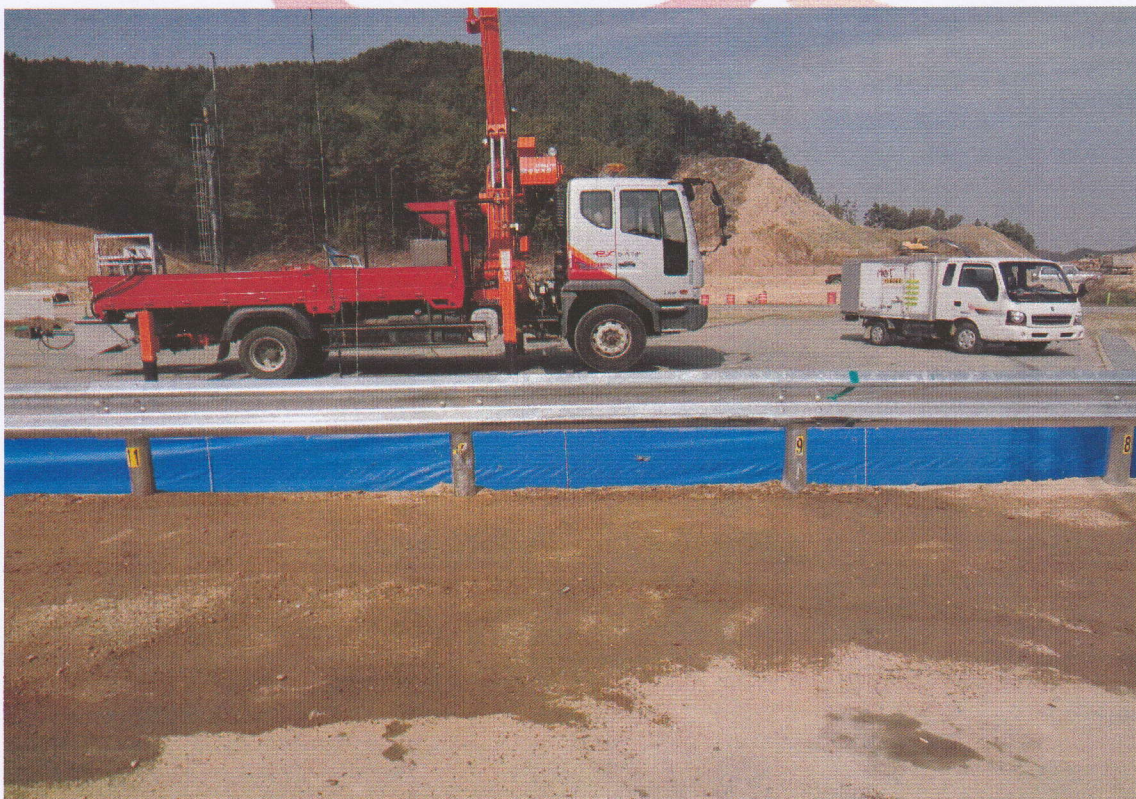
<소형차 시험 후 시설물 전면부>
