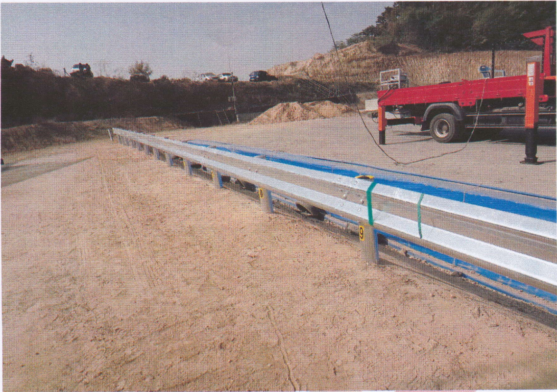
<소형차 시험 전 시설물 설치전경>
