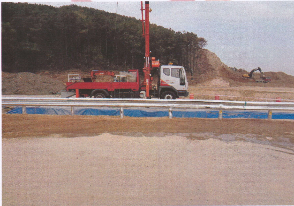
<대형차 시험 후 시설물 전면부>
