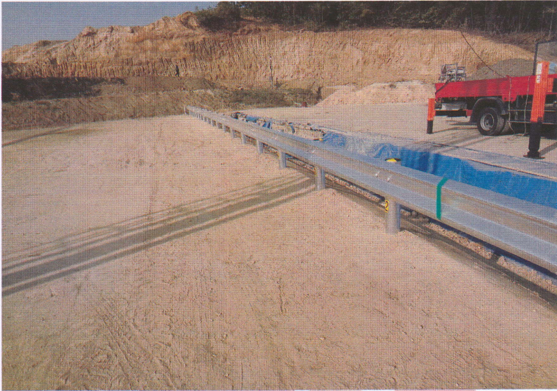
<대형차 시험 전 시설물 설치전경>
