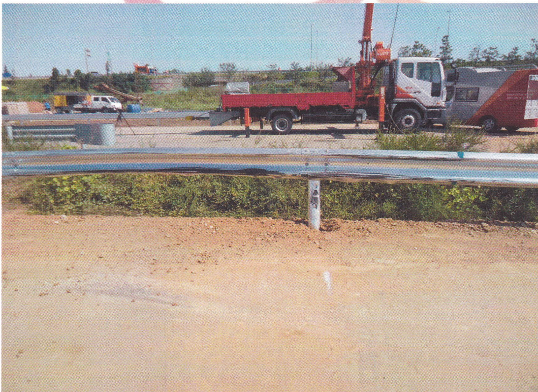
<대형차 시험 후 시설물 전면부>
