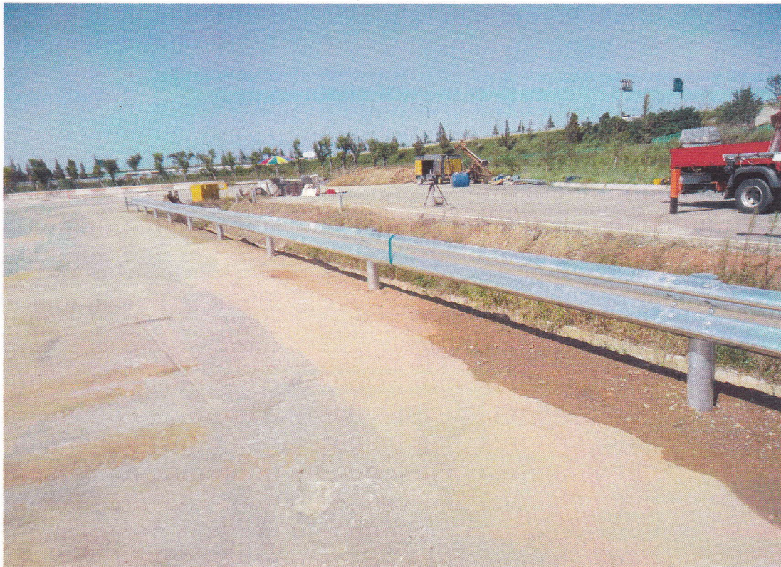
<소형차 시험 전 시설물 설치전경>
