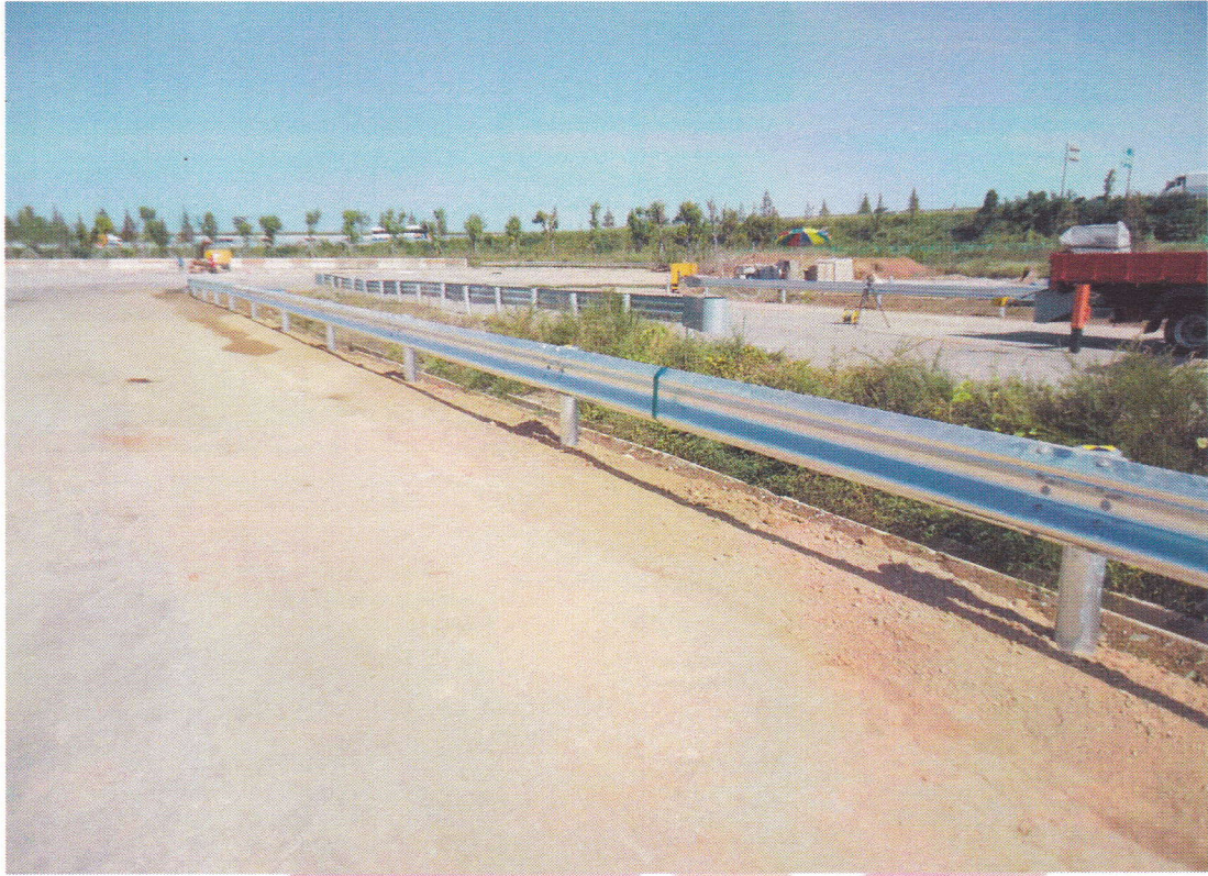
<대형차 시험 전 시설물 설치전경>
