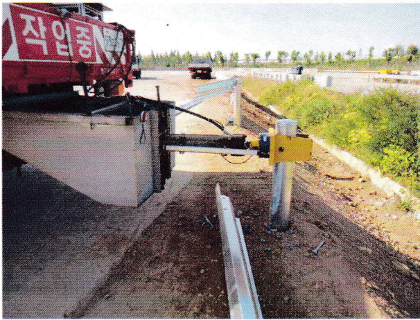
<지주 시험체 설치>
