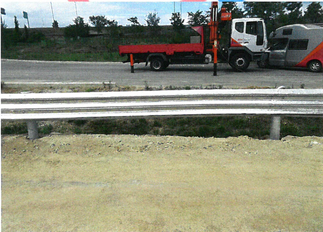
<소형차 시험 후 시설물 전면부>
