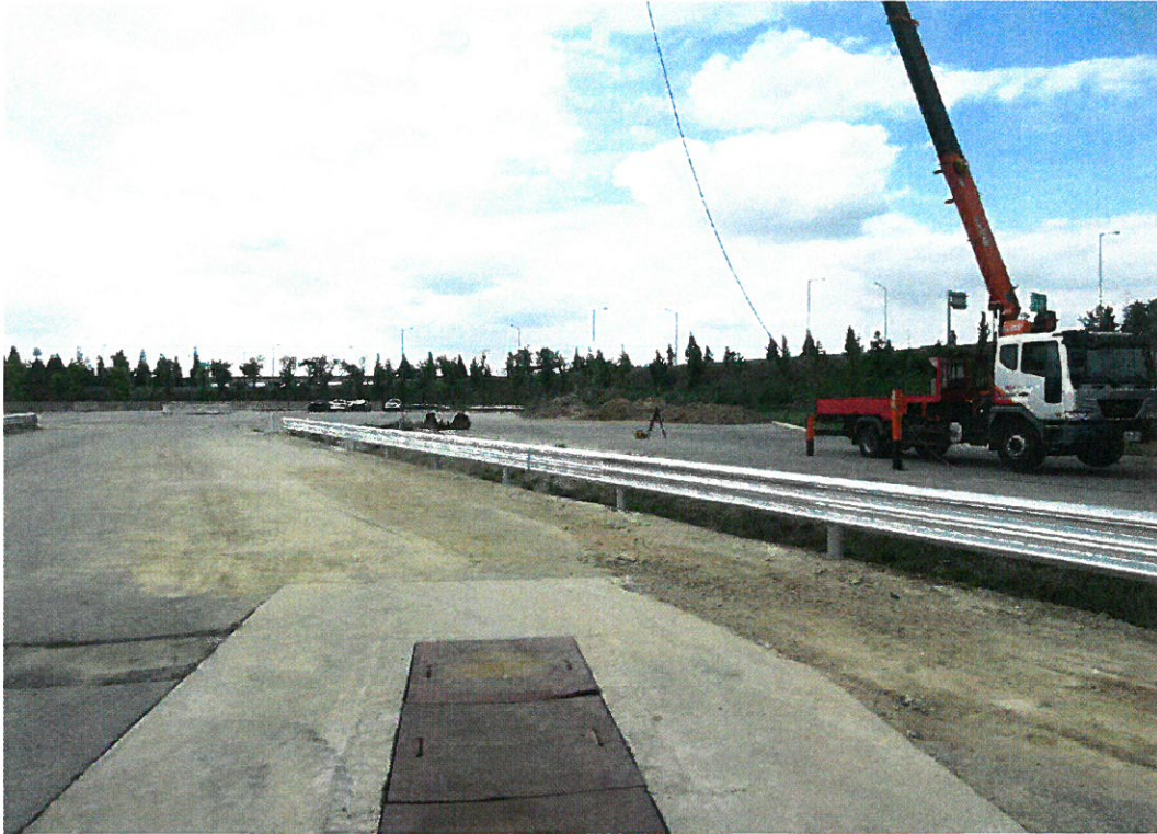
<소형차 시험 전 시설물 설치전경>
