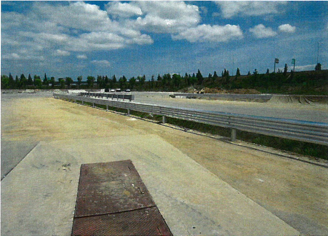
<대형차 시험 전 시설물 설치전경>
