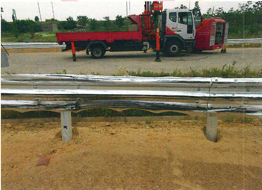
<대형차 시험 후 시설물 전면부>
