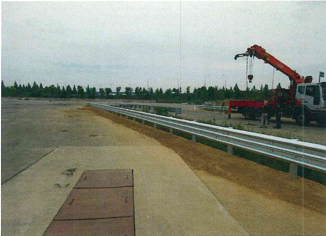
<대형차 시험 전 시설물 설치전경>
