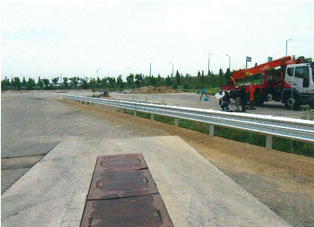
<소형차 시험 전 시설물 설치전경>
