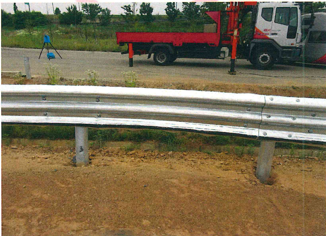
<소형차 시험 후 시설물 전면부>
