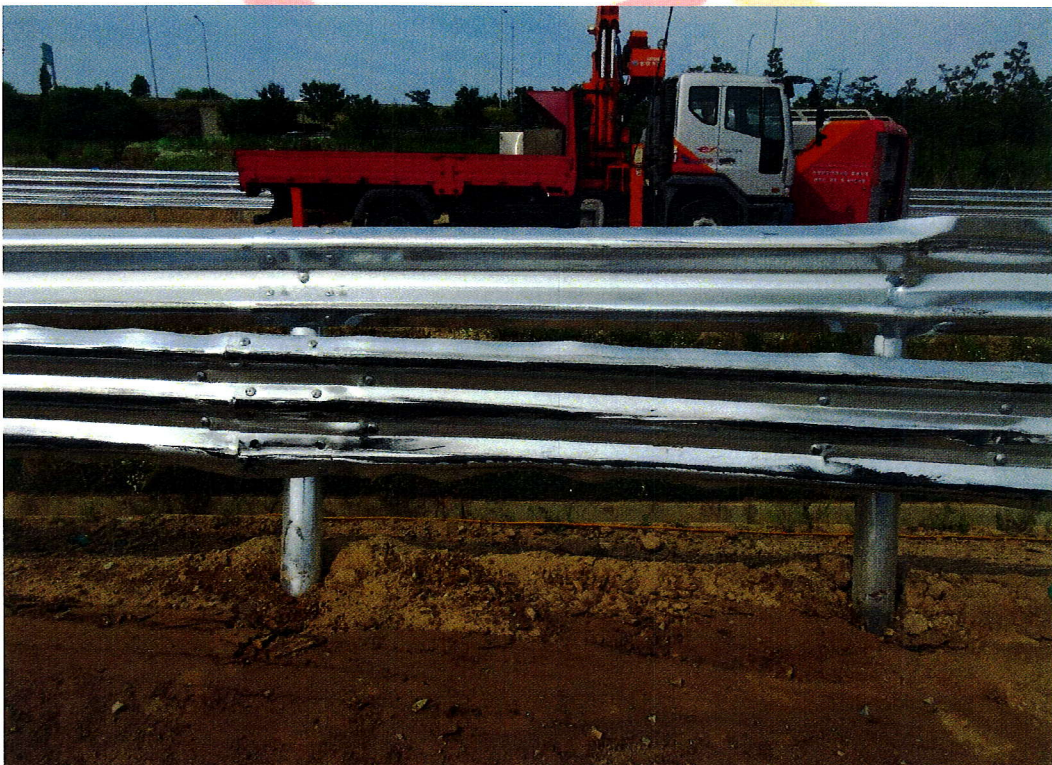
<대형차 시험 후 시설물 전면부>
