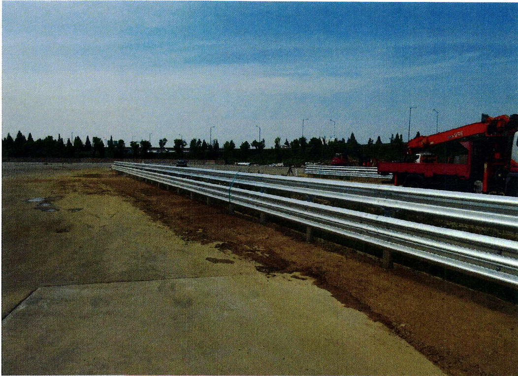
<대형차 시험 전 시설물 설치전경>
