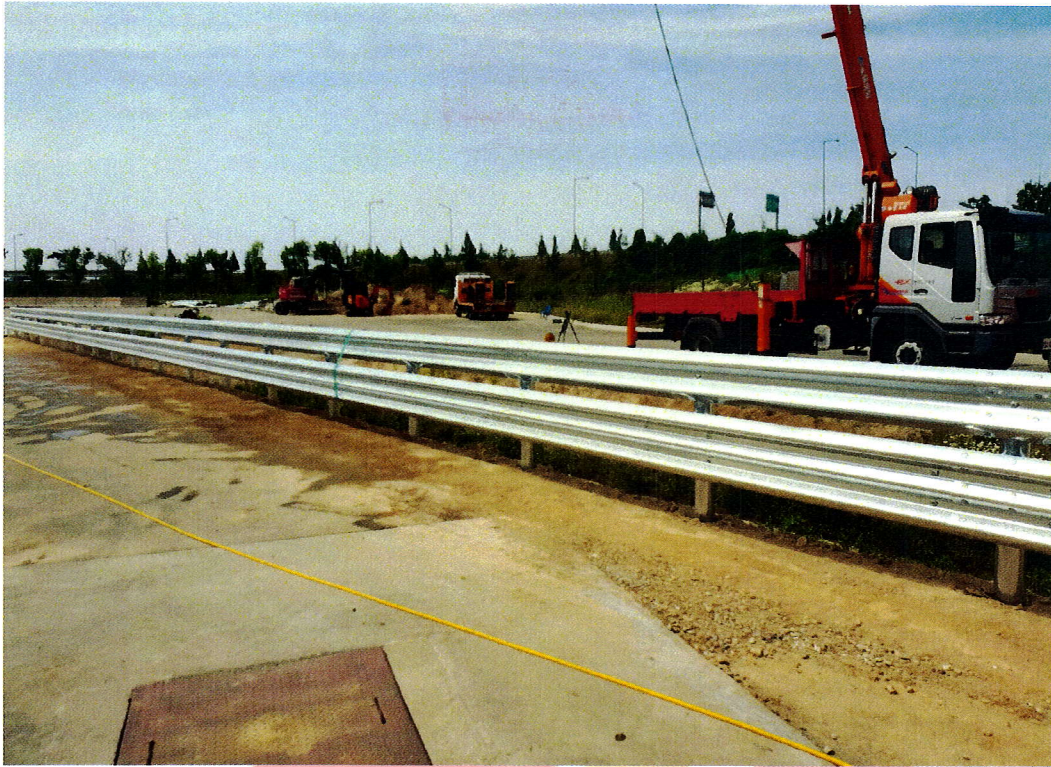
<소형차 시험 전 시설물 설치전경>
