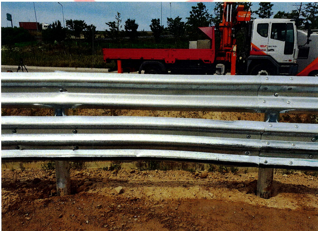
<소형차 시험 후 시설물 전면부>
